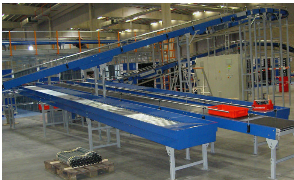
Die Prüfstation am Fördersystem
