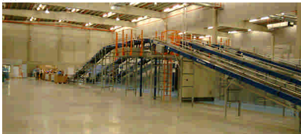
Das neue Fördersystem von Vanderlande
