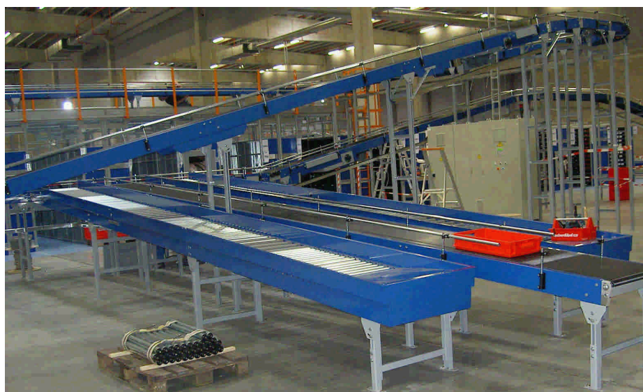
Die Prüfstation am Fördersystem
